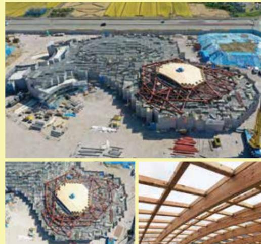
鉄骨と木アーチ梁の建て方がほぼ完了し、建物の形状が分かるようになってきました。今後は屋根工事が始まり、「美しい山並みに呼応する雲」のようにたなびく屋根ができあがります。建物内部ではサッシの取付けも行っており、完成へ向けて一歩進んでいます。
