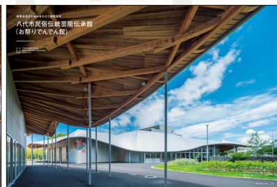
2章「八代市民俗伝統芸能伝承館（お祭りでんでん館）」。 地元の流通材を組み合わせでつくられた曲面の屋根が市民の居場所やお祭りの鉢の組み立て場所となります。 対談：平田晃久氏×藤本壮介氏
